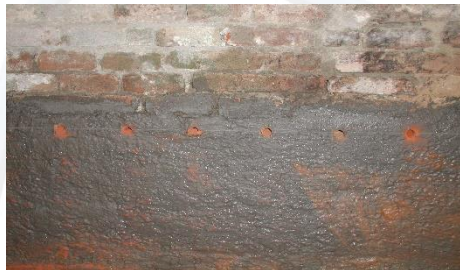
foto1 - esecuzione fori \varnothing 35 cm, interasse 14 cm altezza da terra 18cm -max
