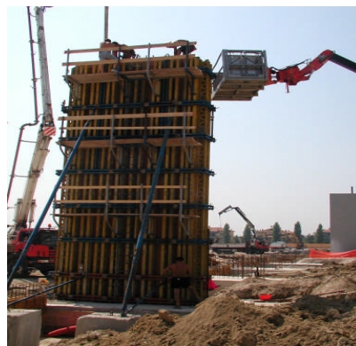
Disarmoface nella cantieristica
