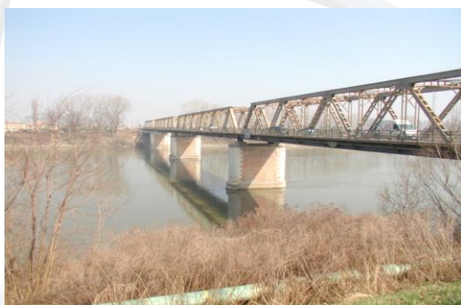
Ponte sul Po fra le prov di Fe e Ro loc S.Maria Maddalena Ripristino del cemento armato degradato
