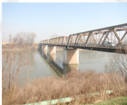
Ponte sul Po fra le prov di Fe e Ro loc S.Maria Maddalena Ripristino del cemento armato degradato
